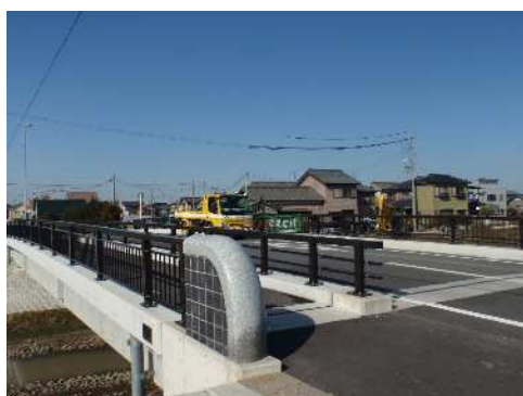
写真2 道路パトロール状況
