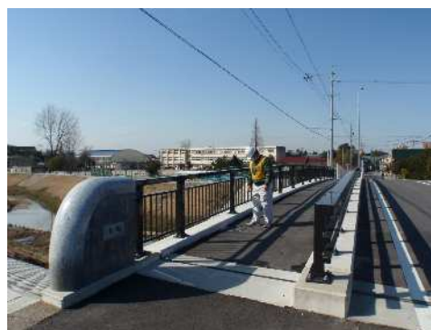
写真3 職員による目視点検状況
