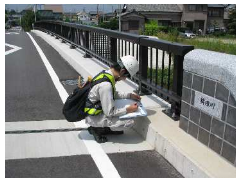
写真1 専門業者による点検状況
